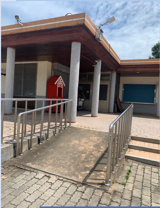
外部展區無障礙通道
